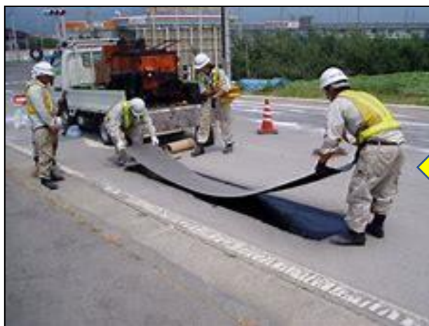
クラック抑制シート設置状況
