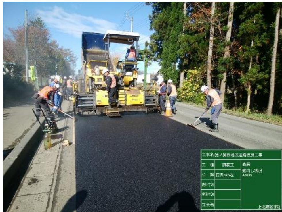
リフレッシュシールMix-H工法による表層施工
